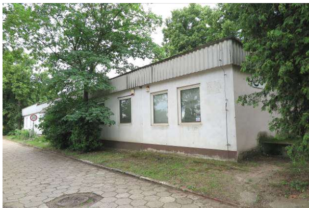
/widok na budynek biurowy/
