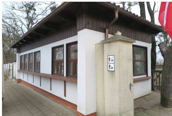
/widok na budynek portierni/
